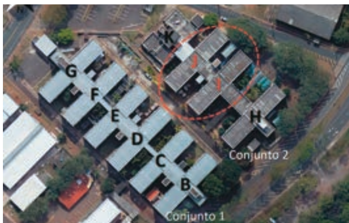
Figura 18.4 Localização dos ambientes do projeto de retrofit de aparelhos de ar-condicionado na FEM.
